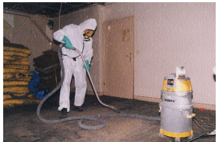
Abb. 14: Reinigungsstätigkeiten mit einem K1-Industriestaubsauger in einem mit Taubenkot verschmutztem Gebäude in Berlin. Tauben hatten seit etwa 1993/94 keinen Zugang mehr zu den Räumlichkeiten
