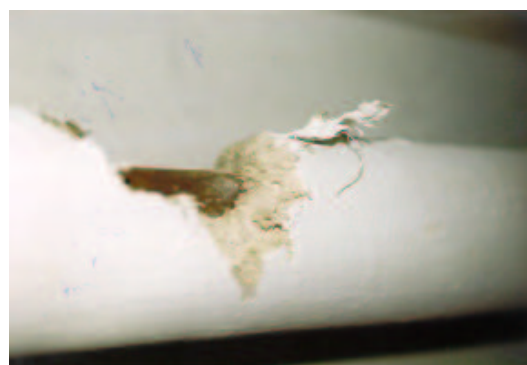
Bild 4: Asbesthaltige Rohrleitungsisolierung
