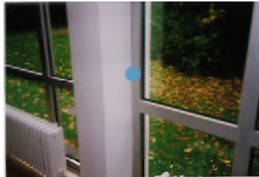
Bild 8: PCB-haltige Fensteranschlussfuge
