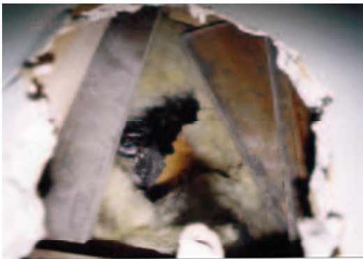
Bild 7: Künstliche Mineralfaser-Isolierung im abgehängten Deckenbereich mit Holzunterkonstruktion
